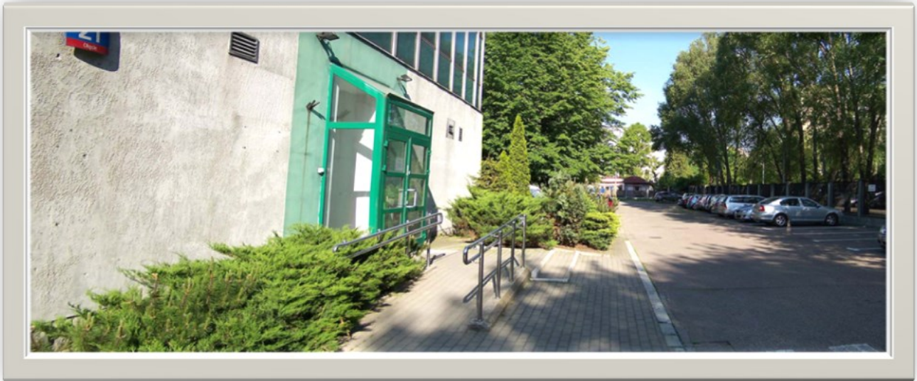
Zdjęcie 6: Widok wzdłuż ulicy 1 Sierpnia (w kierunku bramy p.poż.)
